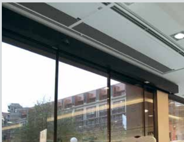
TREND ... -AK monteret i nedhængt loft med blændramme af aluminium – indbygningen er som AWE version
